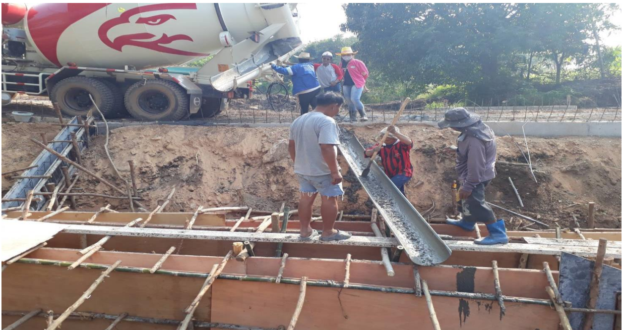
แสดงภาพถ่ายโครงการก่อสร้างฝายน้ำล้นคอนกรีตเสริมเหล็ก หมู่ที่ ๔
